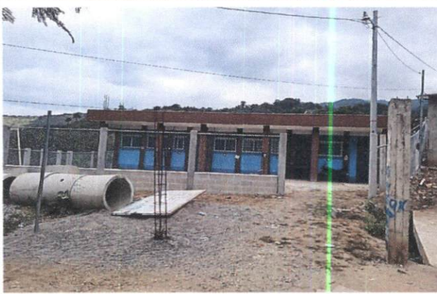
Foto 1: Mejoramiento de muro perimetral del centro educativo, finalizado.
