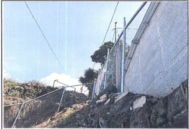
Foto 2: Mejoramiento de muro perimetral del centro educativo, finalizado
